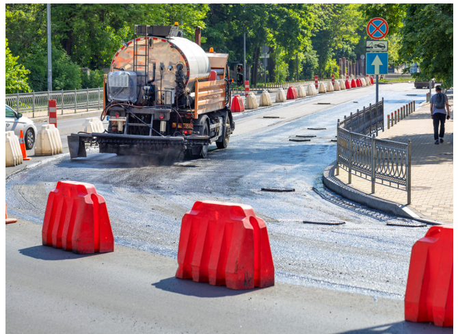
Aanbrengen van de kleeftlaag
