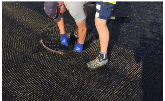
Asfaltwapening kan gemakkelijk worden uitgesneden rond mangaten
