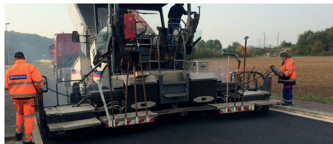
Het aanbrengen van het asfalt over de wapening
