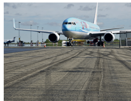
Wapening van de taxibaan van een luchthaven
