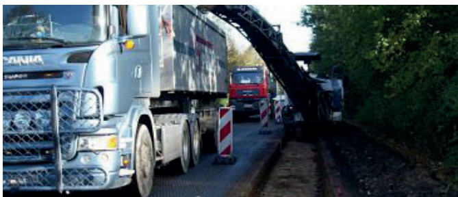
Graafwerkzaamheden aan de rand van de weg
