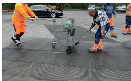
4 Handmatig aanbrengen van S&P asfaltwapening voor lokale versterkingen
