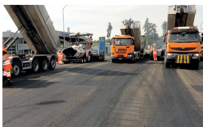
5 Aanbrengen van de deklaag op dezelfde dag
