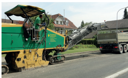
1 Voorbereiding van de wegooppervlakte via frezen of hogedrukreiniging
