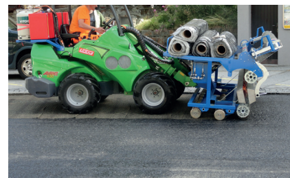
3 Thermisch/mechanisch aanbrengen van de S&P asfaltwapening op de volledige oppervlakte, na binden van de emulsie
