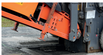
Het frezen van het test oppervlak
