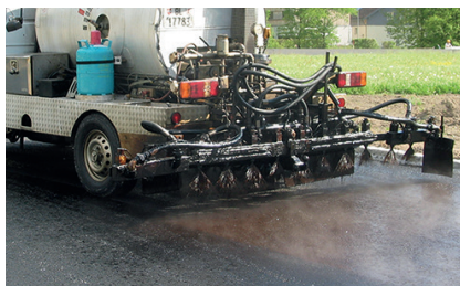
2 Aanbrengen van de hechtingslaag op een droge en stofvrije wegooppervlakte
