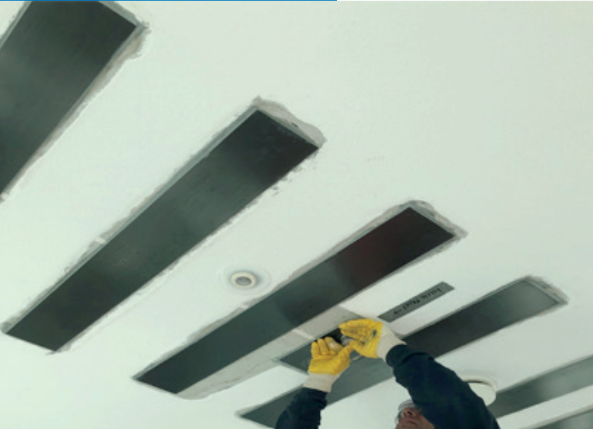
↑ Aanbrengen lamellen onder de breedplaatvloer
