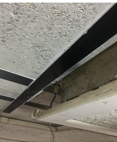
Sparing aanzicht in kelder
