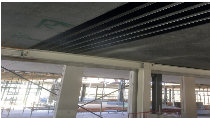
Externe lijmwapening aan de onderzijde constructie
