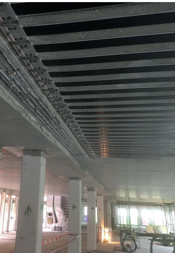
Aangebrachte lamellen met eindankers
