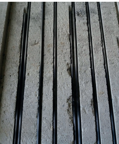
Koolstof bars in de verdiepingsvloer
