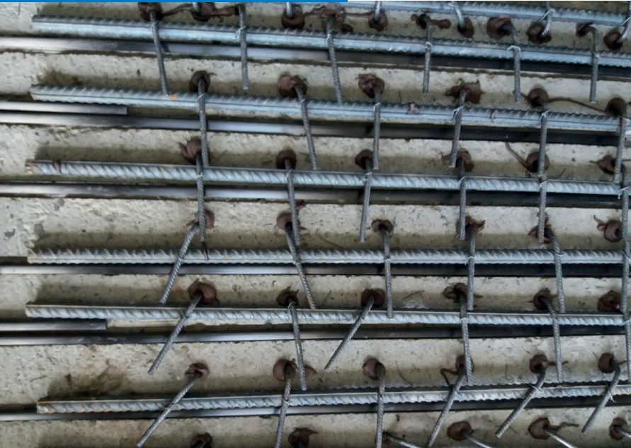
Koolstof bars met staal vastgezet met chemische ankers
