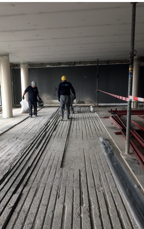
Aanbrengen wapening in verdiepingvloer
