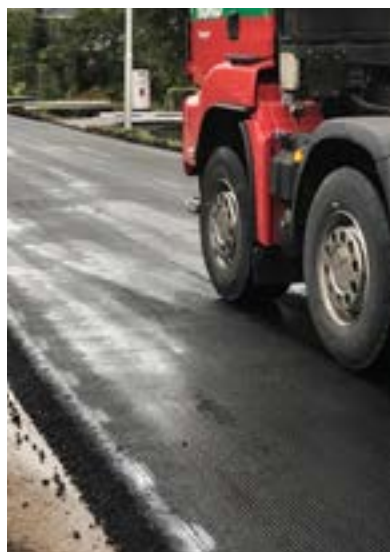
↑ Aanbrengen S&P Carbophalt G 200/200
