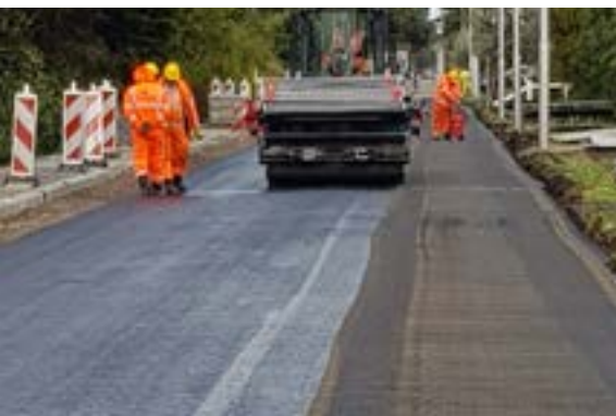
↑ Applicatie van de asfaltwapening
