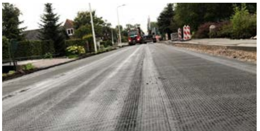
↑ Gereed voor aanbrengen asfalt
