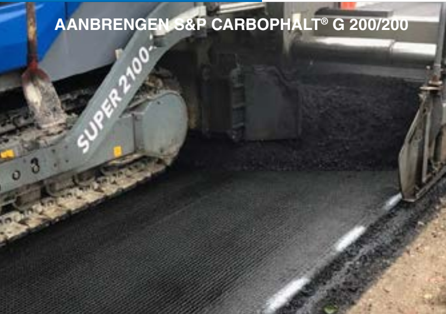
↑ Asfalt aanbrengen op S&P Carbophalt
