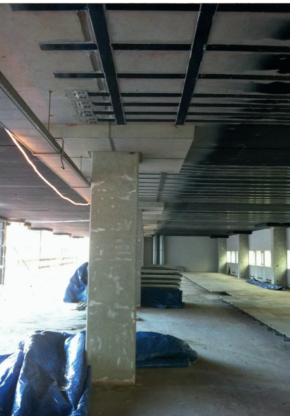
versterking gereed onderzijde verdiepingsvloer
