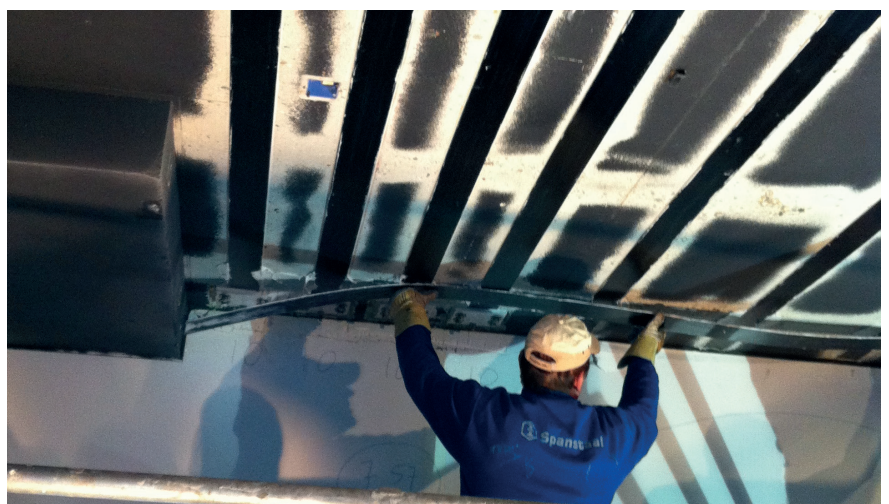
Plaatsen van de koolstoflamellen
