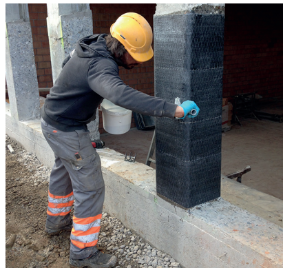
5 S&P C-Sheet (met behulp van omwikkeling axiale versterking van kolommen/pijlers)
