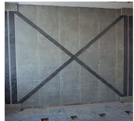
6 Versterking van metselwerk met S&P G-Sheet (Seismische verbetering)
